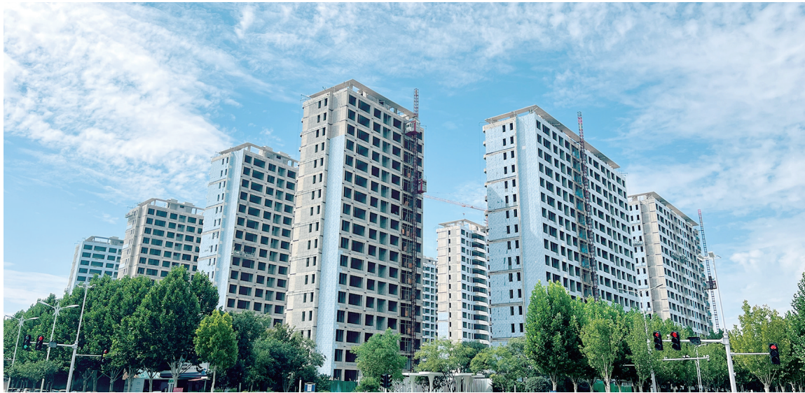
项目外墙立面施工中。
