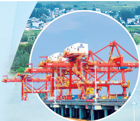
周口中心港中心作业区岸桥耸立。
