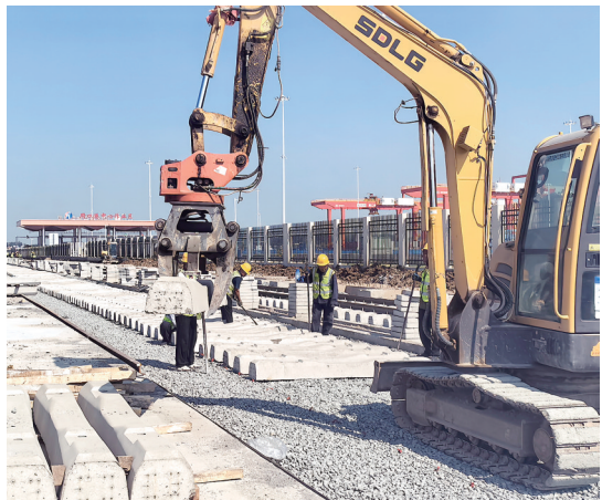
铁路专用线铺设现场。
