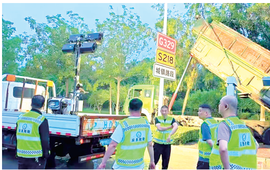
在大清路修建挡水墙。
