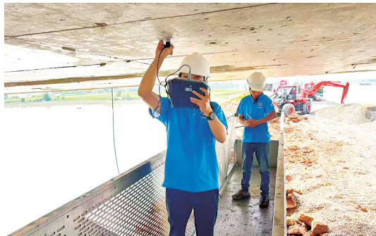
检测北环贾鲁河桥梁安全。
