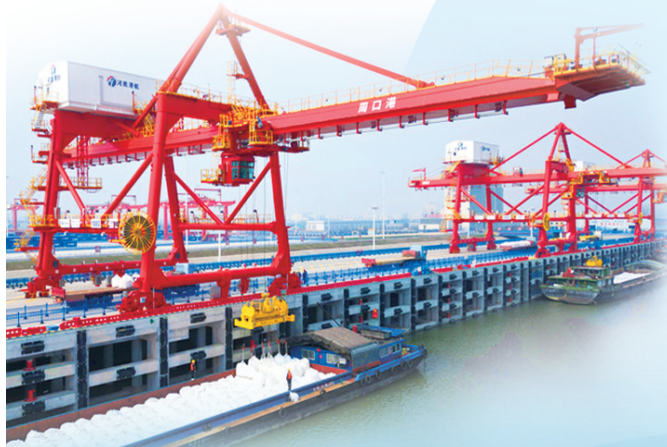
周口港中心港区中心作业区一角。
