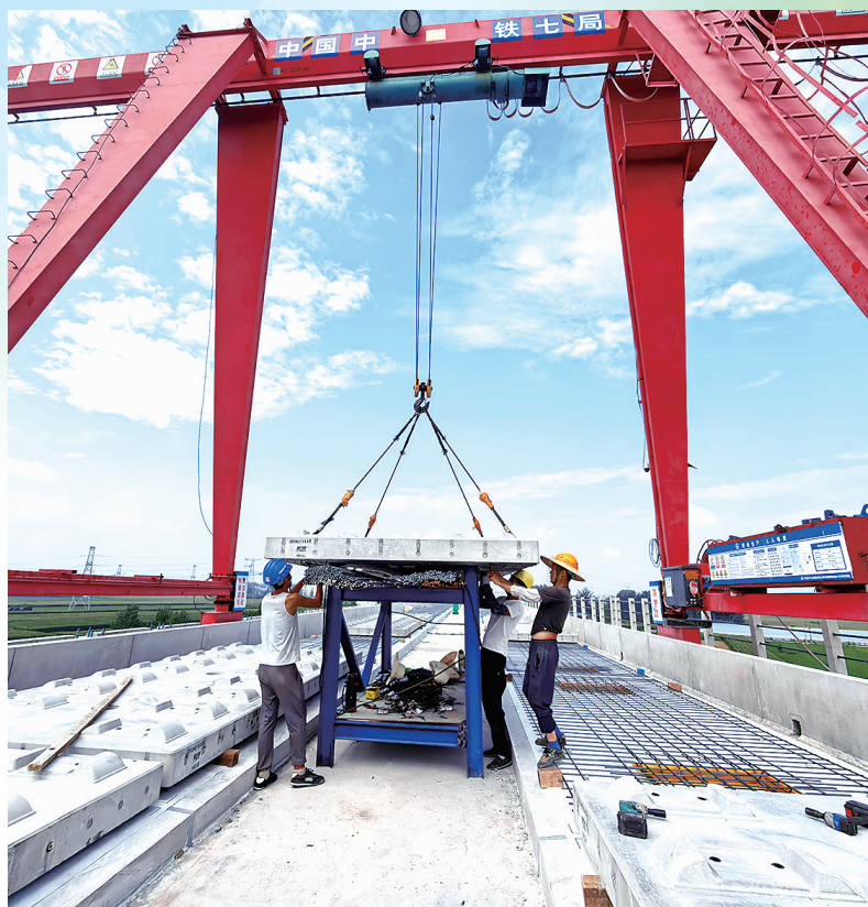
工人在吊卸轨道板。
