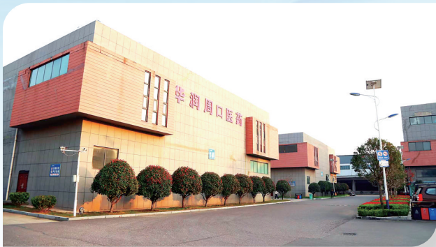
位于安顺仓储物流园的华润周口医药。
