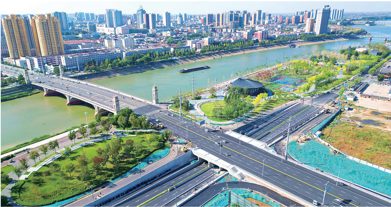
近日,经过一个多月的施工,周口中心城区滨河北路下穿八一大道工程基本完工,已具备通车条件。记者 梁照曾 摄
