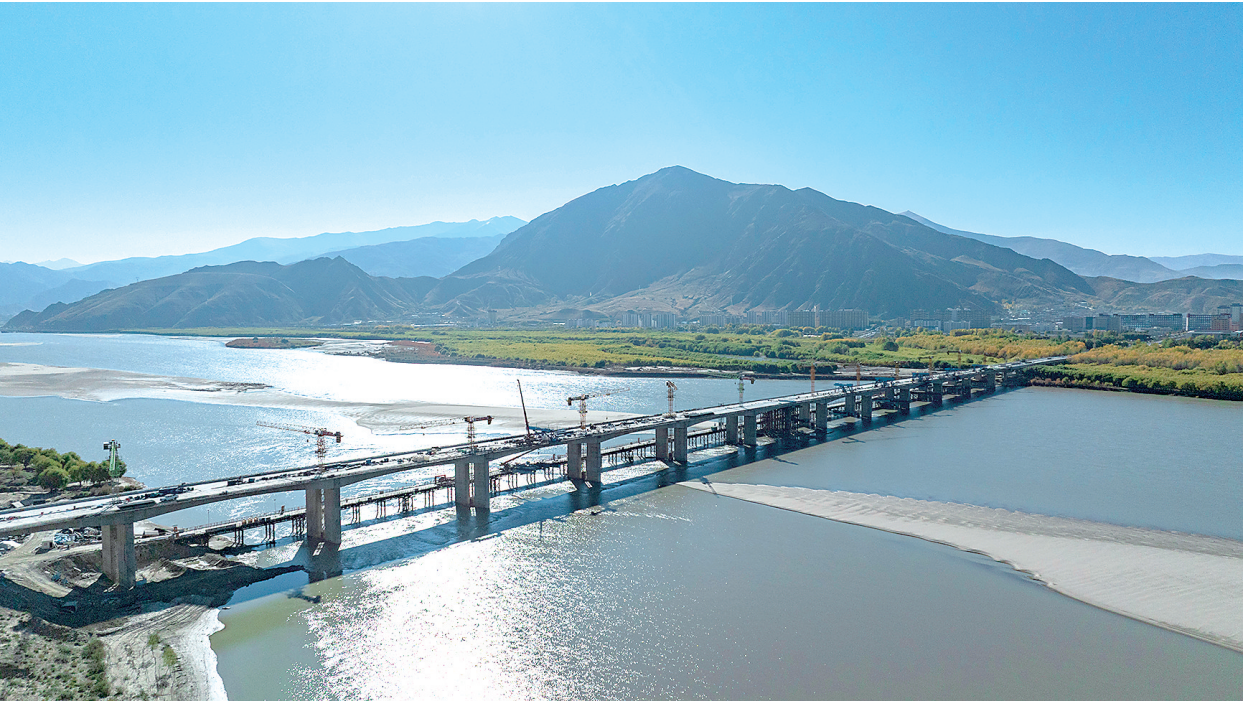
10月18日拍摄的合龙后的西藏山南萨热路跨江大桥(无人机照片)。
