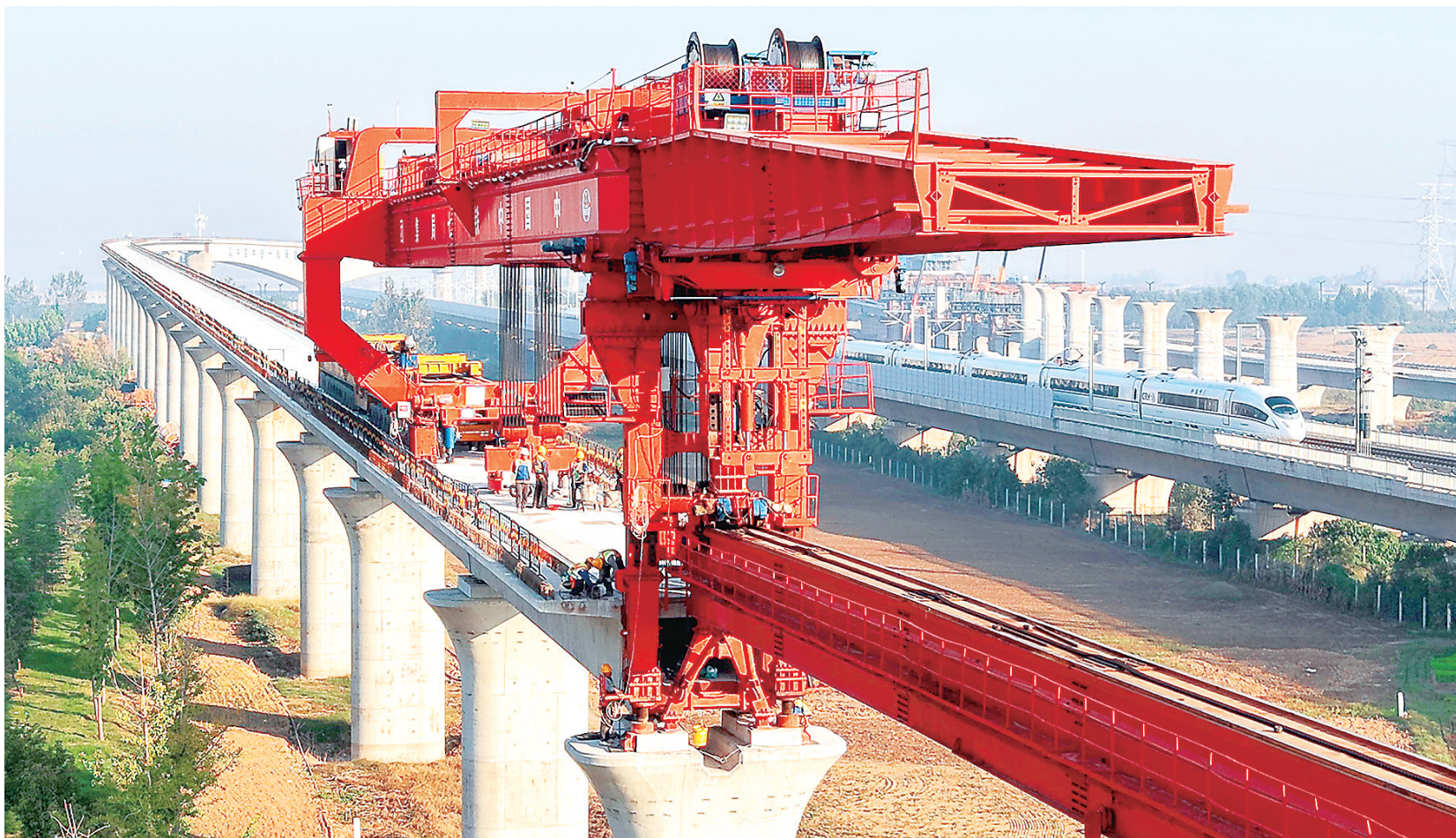
10月9日上午，中铁七局的施工人员在架设平漯周高铁上行线箱梁。目前，平漯周高铁箱梁架设进度加快，距离全线终点高铁周口东站越来越远。施工人员正以高标准、严要求架设“最后一公里”箱梁，为平漯周高铁早日建成通车奠定基础。 记者 梁照曾 摄
