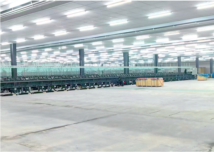
银鑫一通泰3万锭精梳紧密纺节能降碳改造项目现场。
