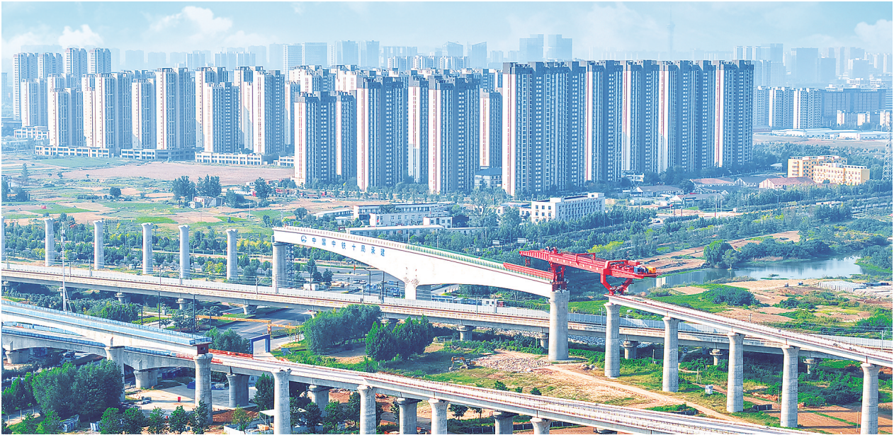
9月18日，平漯周高铁周口段施工现场，架桥机正在进行箱梁架设作业。项目建设者抢抓施工窗口期，稳步推进架梁等工序施工。 作为区域重要高速铁路通道，平漯周高铁建成后将进一步完善豫东南综合交通网络，赋能周口经济高质量发展。 记者 刘俊涛 摄
