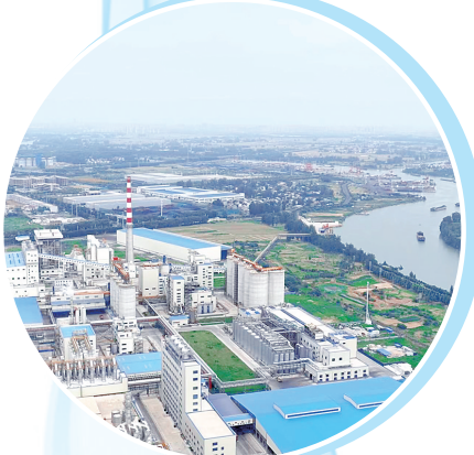
生物化工园区一角。
