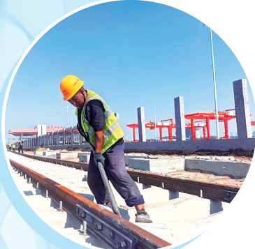
疏港铁路专用线紧张施工。王永剑 摄
