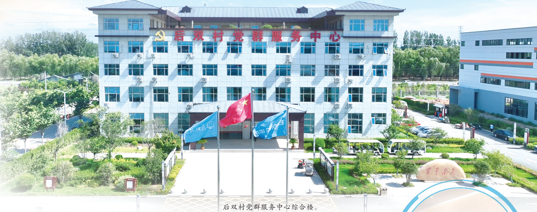
后双村党群服务中心综合楼。
