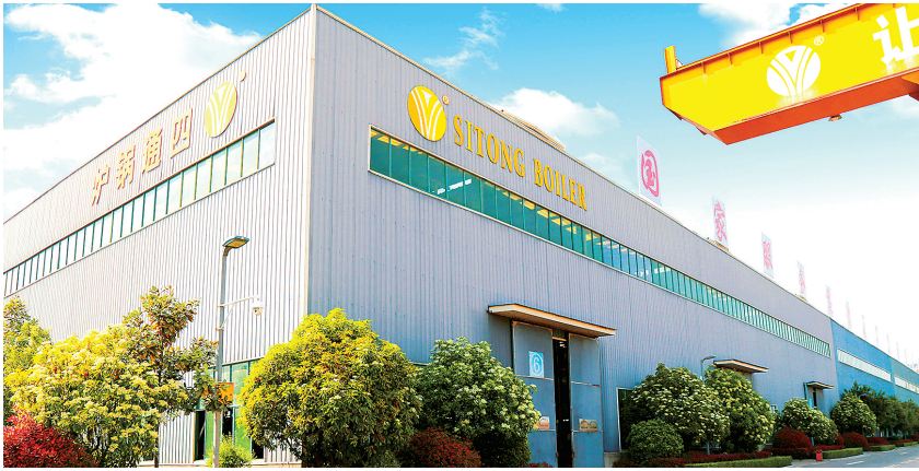
河南四通锅炉有限公司一角。记者 张洪涛 摄
