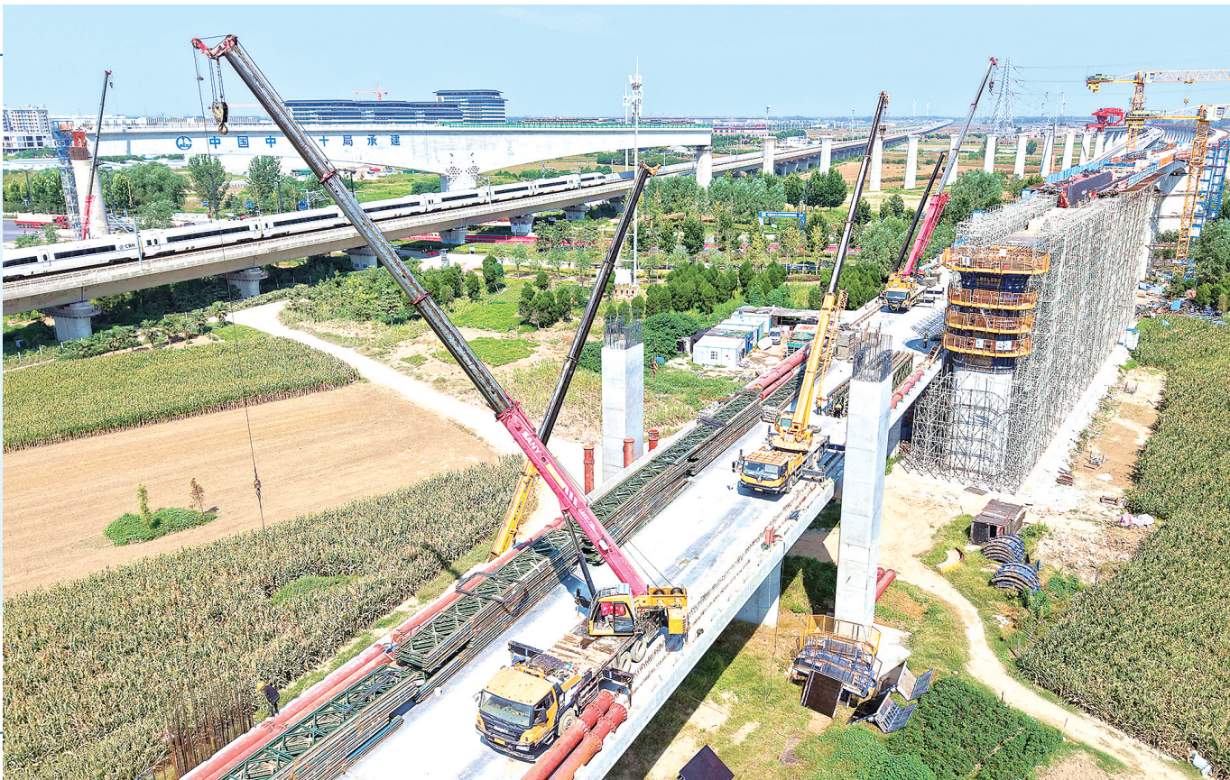
9月7日上午，中铁十局的施工人员在太清路南側进行平漯周高铁跨路箱梁施工。该箱梁全长78米，为现浇简支箱梁，是平漯周高铁周口段最后一个跨高速铁路线的箱梁。平漯周高铁建成后，这里将呈现高铁列车立体通行的景象。 记者 梁照曾 摄
