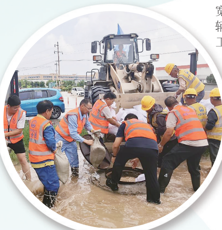
▲8月14日,中铁七局南京公司平漯周高铁项目部在贾鲁河西华险工段加固围堰。 记者 王永剑 摄
