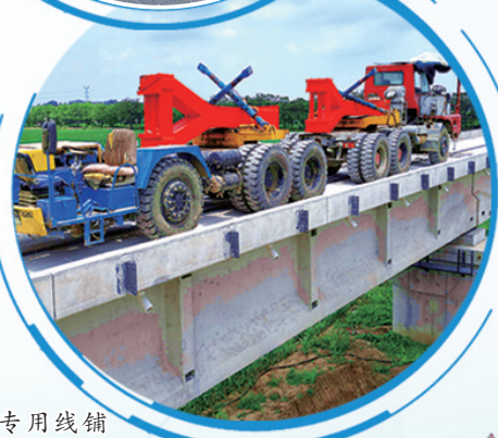
疏港铁路专用线铺轨紧张进行中。
