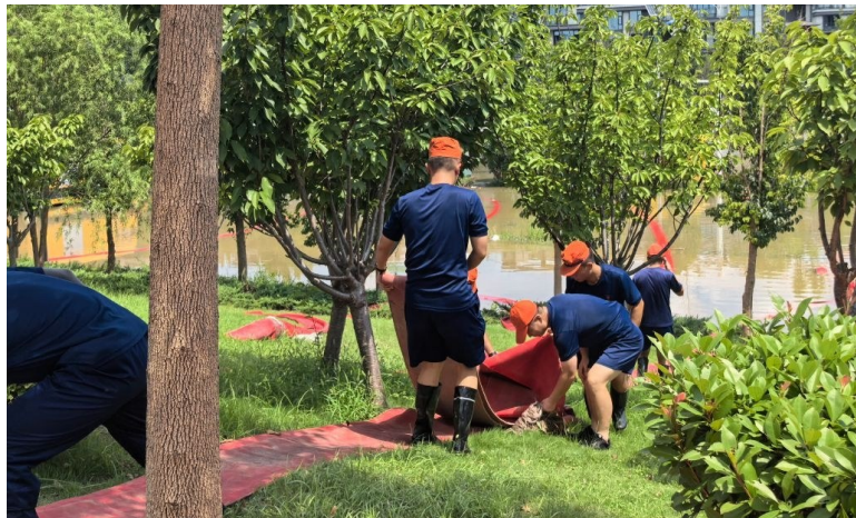
8月16日上午,河南省周口市部分积水区域,工作人员抓紧铺设排水管线,全力开展排涝作业,保障群众生产生活秩序尽快恢复。
