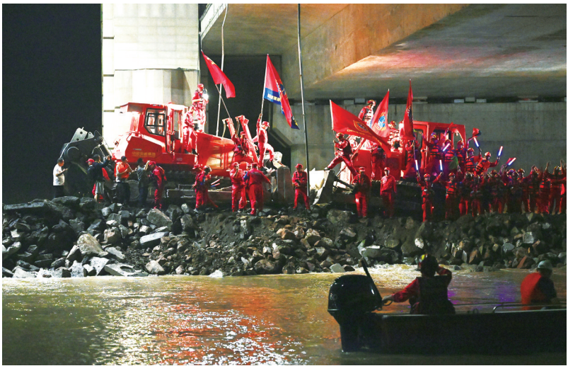
8 月 15 日晚，河南周口贾鲁河堤防溃口合龙。
