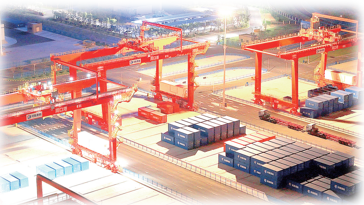
8月6日夜，周口港中心港区中心作业区灯火通明，繁忙而有序的夜间作业场景生动展现了沙颍河“黄金水道”航运产业的强劲动能。记者 刘俊涛 摄
