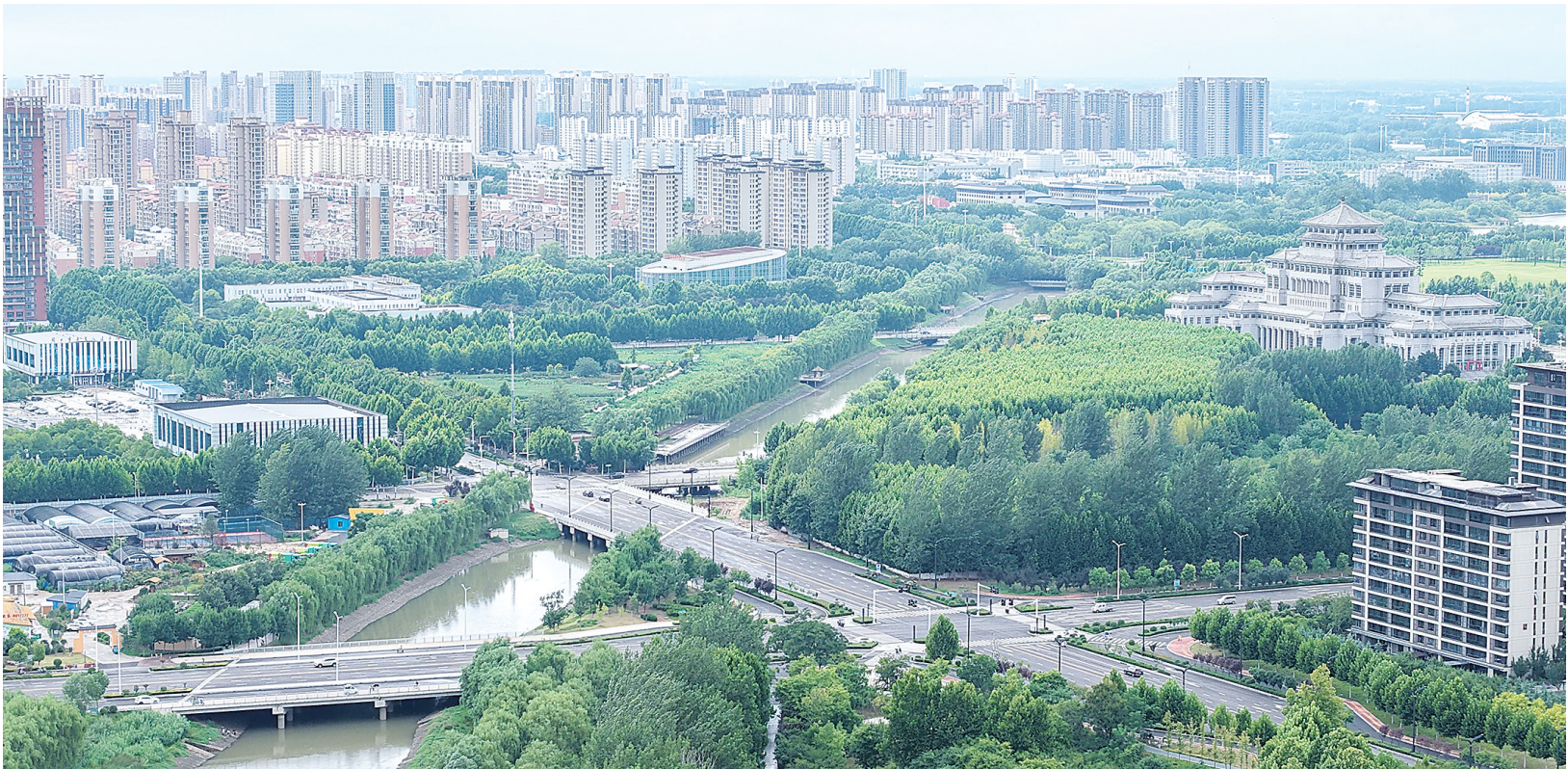
8月5日,俯瞰周口市中心城区,水系绕城蜿蜒贯通,两岸林木繁茂、绿意盎然,铺就厚重生态底色;城市道路纵横通达,楼宇住宅错落分布,城市格局舒展开阔。标志性建筑周口市博物馆静静映在葱茏绿意间,人文地标与自然景致相融共生,尽显周口生态宜居的城市新风貌。
