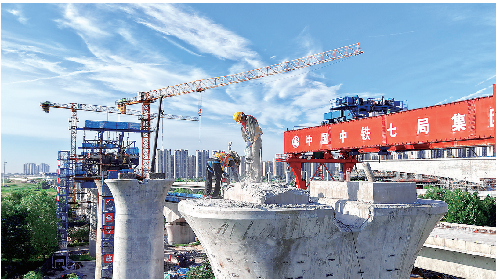
8月2日上午，平漯周高铁跨太清路项目施工现场，施工人员在桥墩上紧张作业，稳步推进建设进度，确保项目如期完工。
