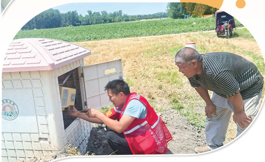
维修农用设施。
