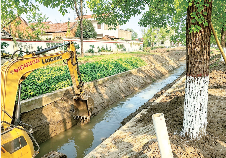
挖掘机在清理沟渠。
