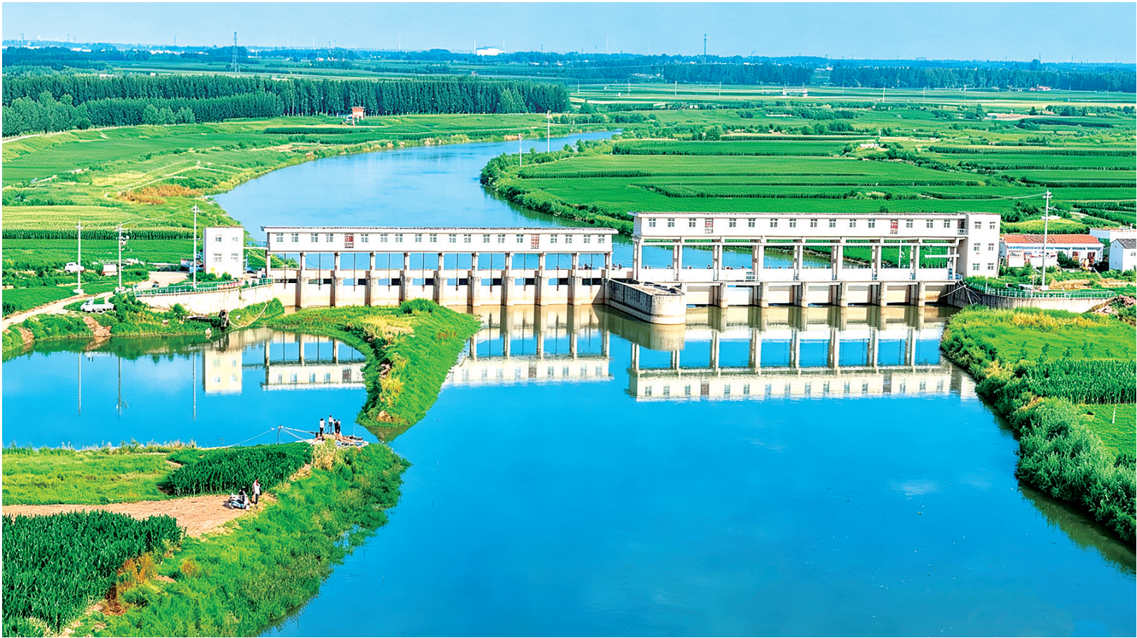
7月26日，扶沟县曹里乡摆渡口大闸矗立于贾鲁河上，碧水映闸，两岸良田绵延铺展，勾勒出一幅美丽的豫东水乡生态画卷。 黄金峰 摄
