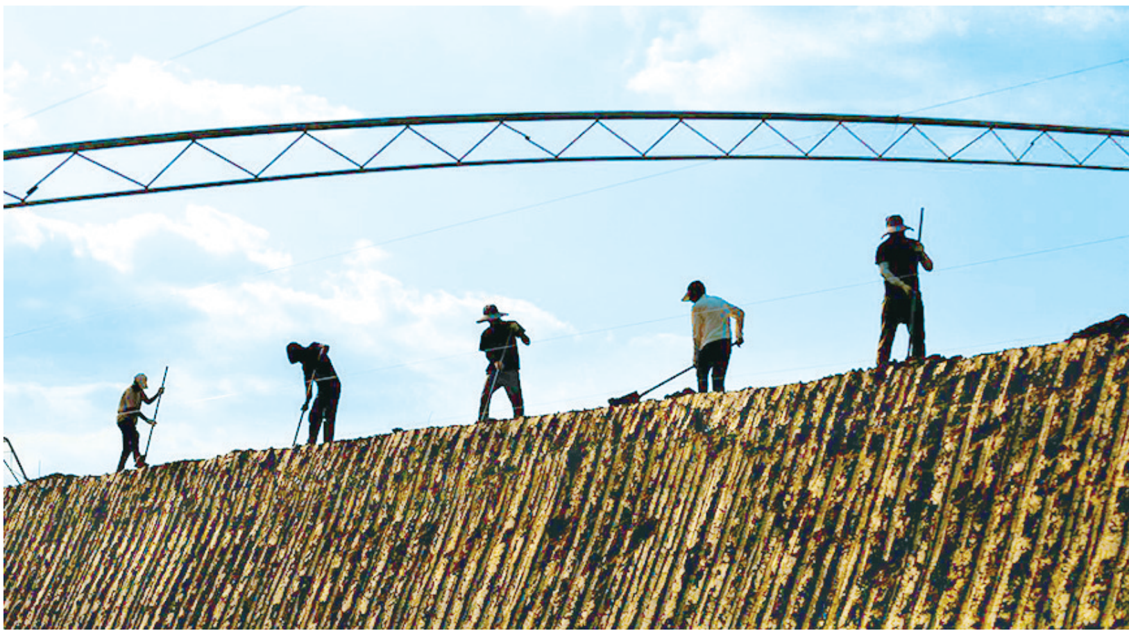
7 月 22 日，郸城县丹阳街道刘双庙行政村 200 亩连片阳光温室蔬菜大棚项目正在抓紧建设。施工现场，工人们有序搭建棚体，忙碌的身影在阳光下跃动成乡村振兴的最美剪影。 柴元红 摄
