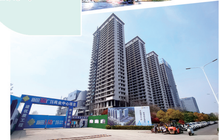
新田360广场项目主体完工。
