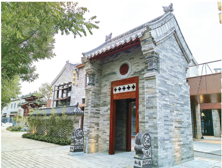
7月16日上午,周口“川上悦”招商盛典暨城市微度假发布会在周口迎宾馆举行。据了解,该项目是我市关帝庙历史文化街区更新改造项目二期工程。未来,随着商家的入驻,这里将成为我市的又一处网红打卡地。图为“川上悦”项目一角。
