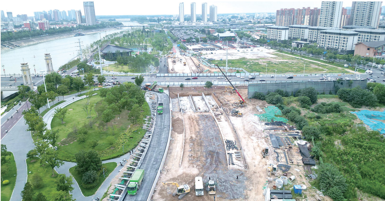
7月15日下午,在中心城区滨河北路下穿八一大道项目现场,施工人員正在紧张施工。该路建成通车后,不仅打通了沙颍河文旅观光带的“断头路”,还将促进中心城区文旅融合发展。
