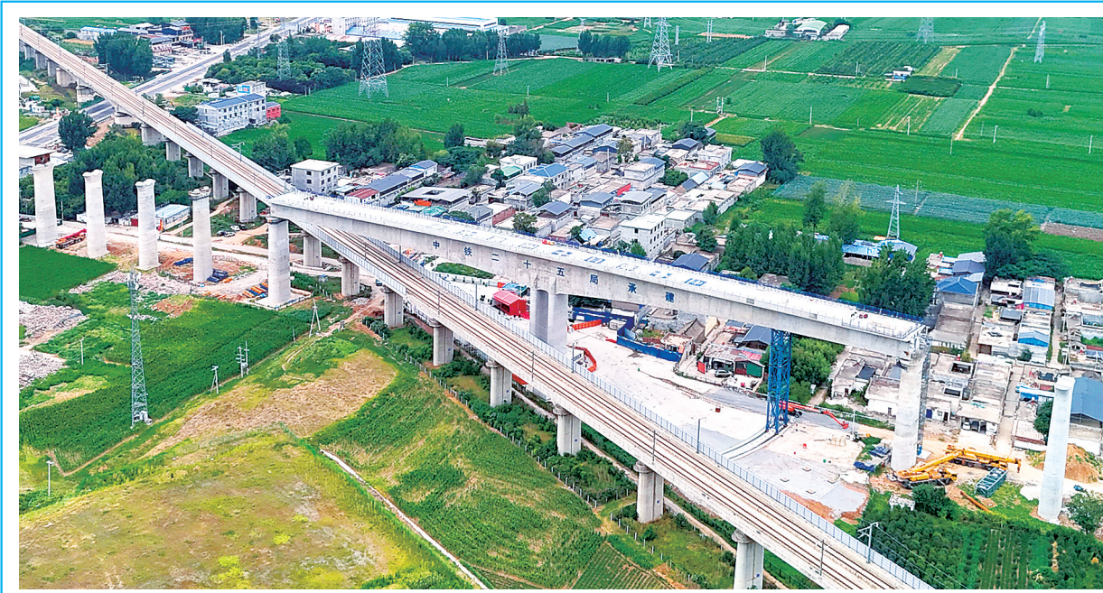
这是7月15日拍摄的成功转体后的河南平漯周高铁鲁湛特大桥跨郑渝高铁施工现场（无人机照片）。
