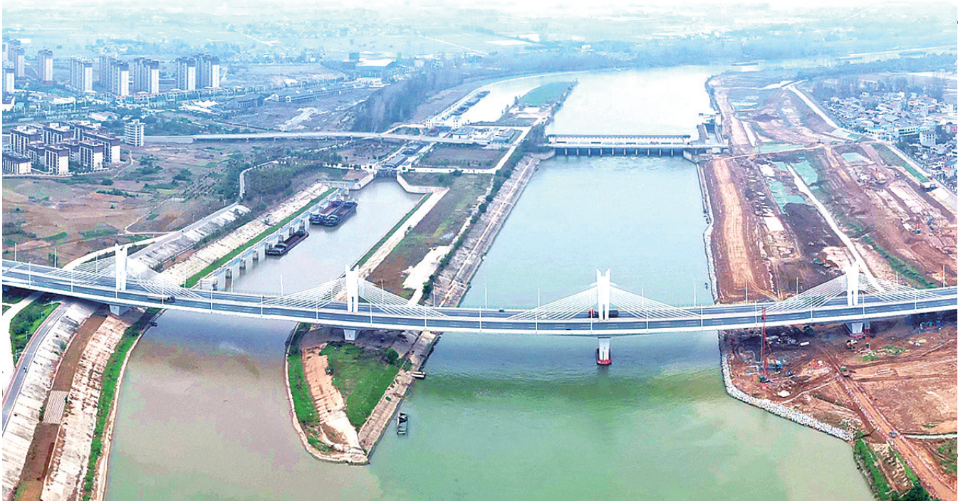
10月23日,中铁广州工程局郑汴口一线船闸改扩建工程项目部抢抓冬季枯水期施工窗口期,掀起“大干100天”工作热潮。建成后,沙颍河郑汴口枢纽将形成独特的“双闸夹河”航运景观。 记者 梁照曾 通讯员 田建军 摄
